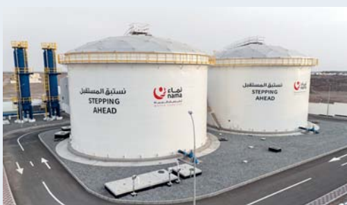
■ رفع كفاءة البنية الأساسية وتأهيل شبكات المياه والصرف الصحي
