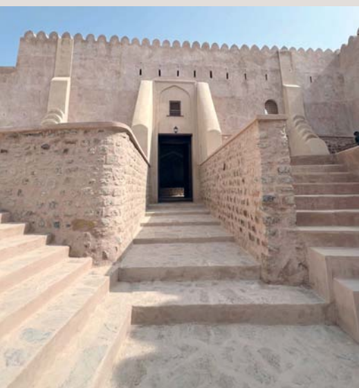
■ أعمال المشروع شملت تنفيذ عدد من أعمال الصيانة والترميم
