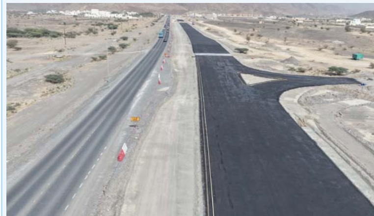
تطوير شبكة الطرق ورفع كفاءتها
