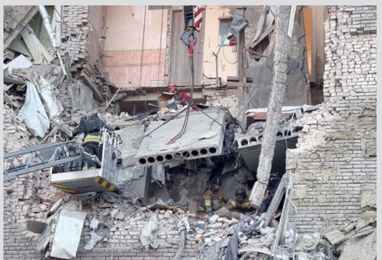
■ فرق إنقاذ تنتشل جثة من بين أنقاض مبنى سكني دُمّر جزئياً إثر ضربة روسية في زابورجيا
