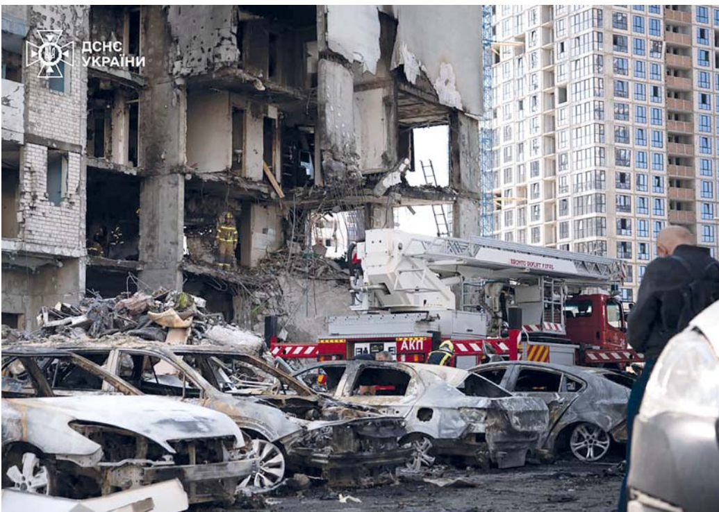
■ مركبات محترقة متوقفة خارج مبنى سكني متعدد الطوابق تعرض لدمار جزئي جراء ضربة صاروخية روسية استهدفت العاصمة الأوكرانية كييف. (أ. ف. ب.)
