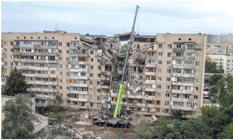
مبنى سكني تعرض لدمار جزئي جراء ضربة صاروخية روسية استهدفت العاصمة الأوكرانية «كييف».
