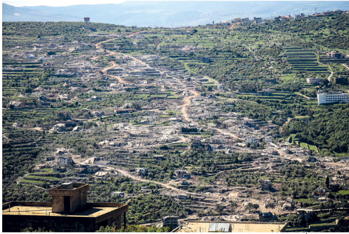
صورة عامة تظهر منازل ومنشآت مدممة دمرها الجيش الإسرائيلي، في قرية بيت ليف قضاء بنت جبيل جنوب لبنان.
