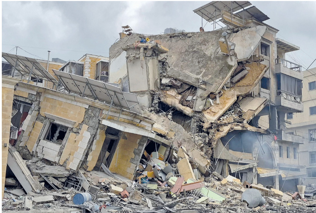
مبنى منهار عقب قصف «إسرائيلي» في النبطية جنوب لبنان.
