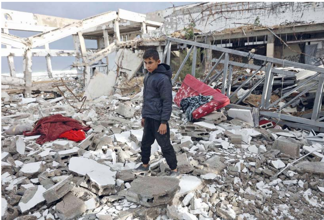
■ فتى فلسطيني يتفقد الأضرار داخل مبنى متضرر من جراء العدوان الإسرائيلي في يوم شتوي بمدينة غزة
