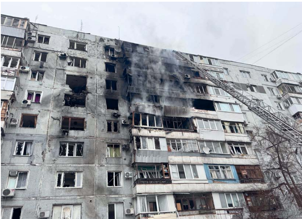
■ مبنى سكني متضرر جراء غارة جوية في زابوريجيا
