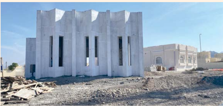
أعمال البناء متواصلة بجهود أصحاب الخير
