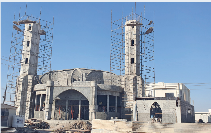
■ تكلفة إنشاء المسجد تقدّر بنحو ٢٥٠ ألف ريال عماني
