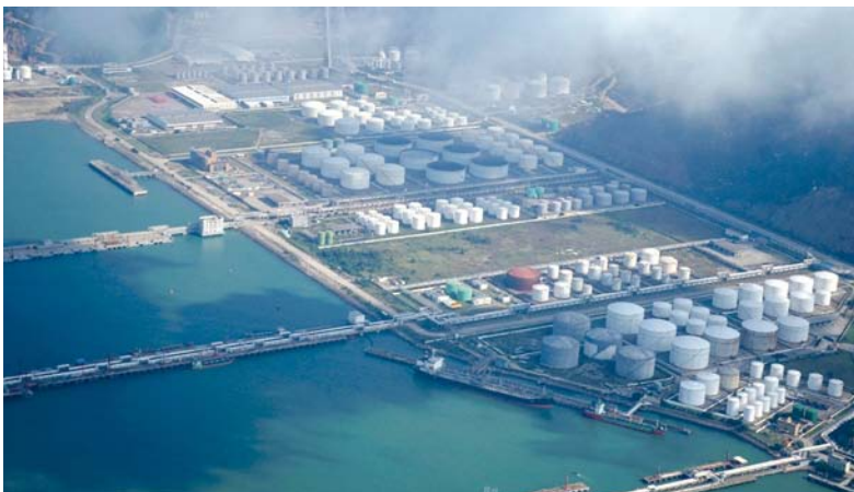
■ صورة ارشيفية لخزانات نفط وغاز في ميناء تشوهاي بالصين
