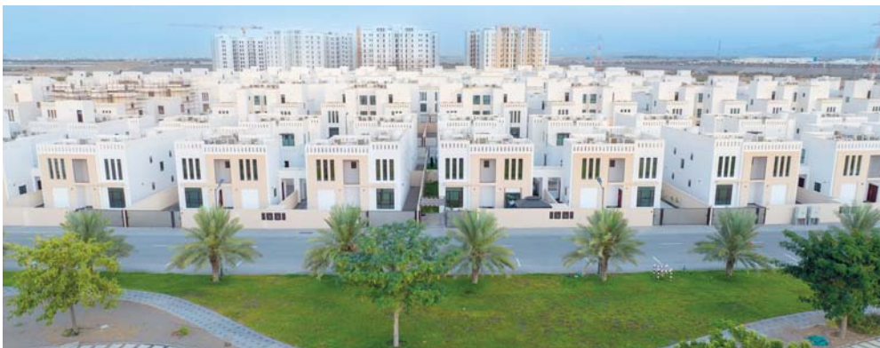
■ دعم جاهزية المباني الحديثة لمواكبة تطور خدمات الاتصالات
