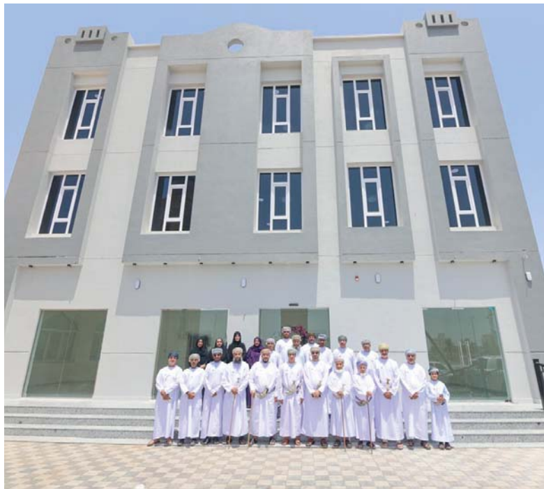
المبنى أقيم على مساحة بناء ١٥٠٧ أمتار مربعة
