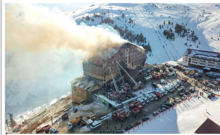
منظر جوي لحريق بمنجوع كارتالكايا للتزلج في مقاطعة بولو وسط تركيا، حيث قضى ما لا يقل عن ٧٦ شخصاً في الحريق بعد ارتفاع عدد الضحايا أمس.
