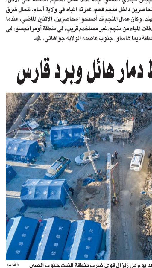
منظر جوي يظهر المباني المنهارة وخيام المساعدات بعد يوم من زلزال قوي ضرب منطقة التبت جنوب الصين
