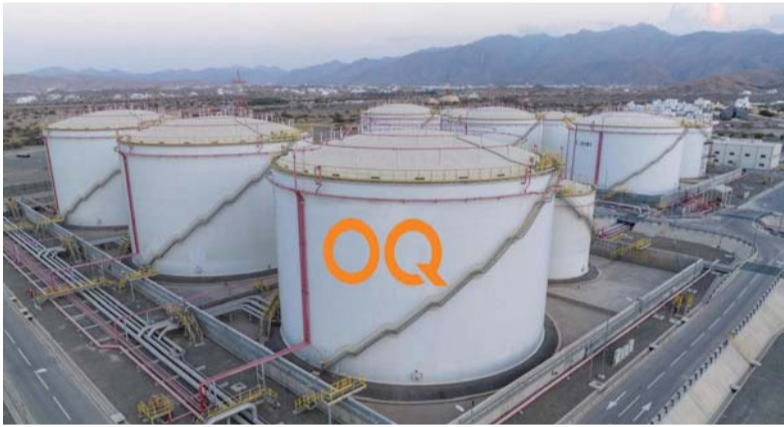
■ المشروع يساهم في تعزيز منظومة خزانات الوقود الاستراتيجية في الحالات الطارئة
