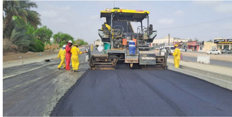
■ الأسفلت المعدل بالمطاط مقاوم للتشقق والتآكل والتأثيرات الحرارية
