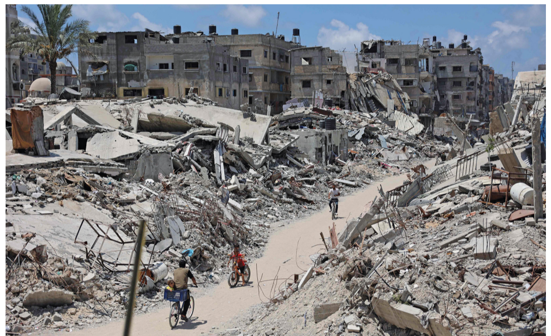
فلسطينيون يمشون عبر مبانٍ مدمرة سُويت بالأرض جراء العدوان الإسرائيلي على بيت لاهيا شمال قطاع غزة
