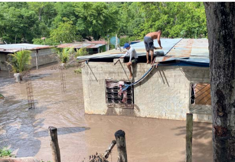
شخصان يقومان بإصلاح سقف منزلهما الذي غمرته المياه بعد أمطار غزيرة جراء مرور إعصار بيريل في ولاية سوكري بغنزويلا.
