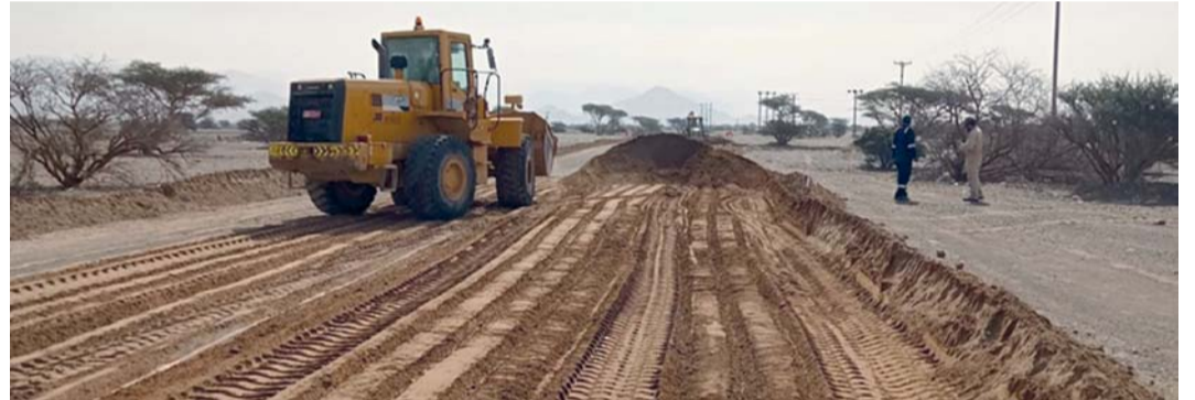
أثناء رصف أحد الطرق بالولاية
