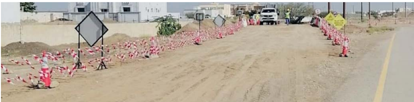
أثناء أعمال صيانة الطريق
