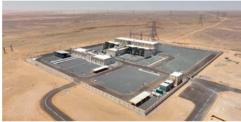
المشروع يربط شبكة النقل الرئيسية بشبكة كهرباء ظفار
