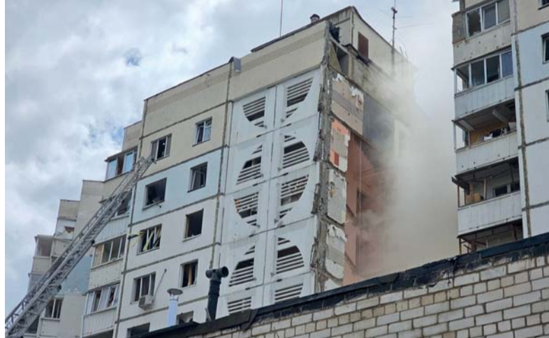
مبنى سكني انهار جزئياً بعد أن تضرر بسبب غارة أوكرائية في بيلجورود بروسيا
