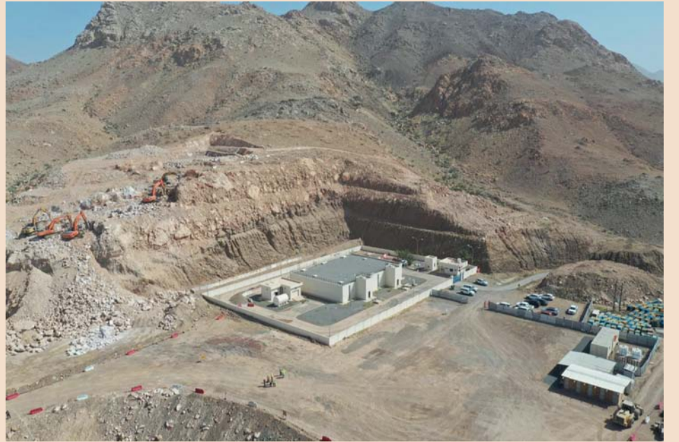
تهيئة الموقع لخزان المياه
